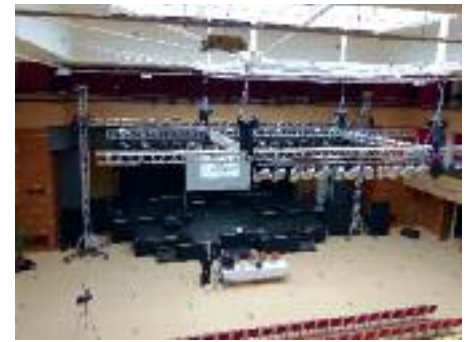
Befüggesztett technológiarács a multifunkciós teremben
