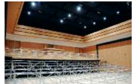
Az elbontható nézőtéri széksorok szerelése
