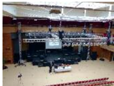
Befüggesztett technológiarács a multifunkciós teremben
