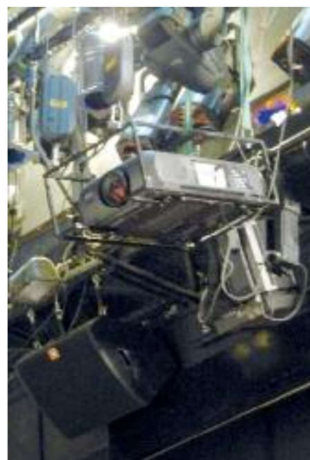
7. ábra Projektor a világítási hídra függesztve
