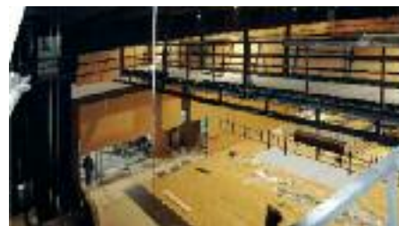
Mozgó világítási híd a hangversenyteremben szerelés közben
