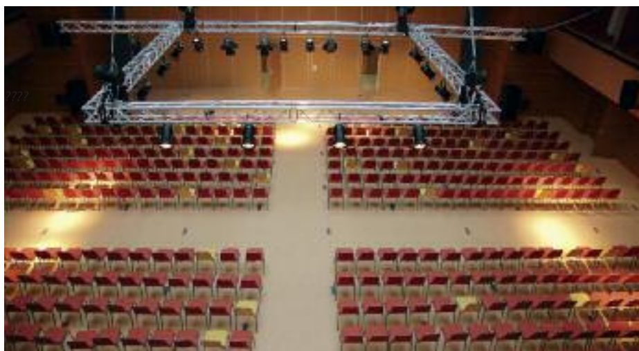
Multifunkciós terem befüggesztett csőtartó rendszere
