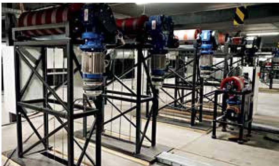
► A nagyterem kötélidos gépei a zsinórpadláson
