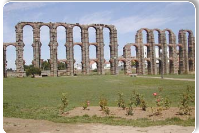
Aqueducto de los Milagros
