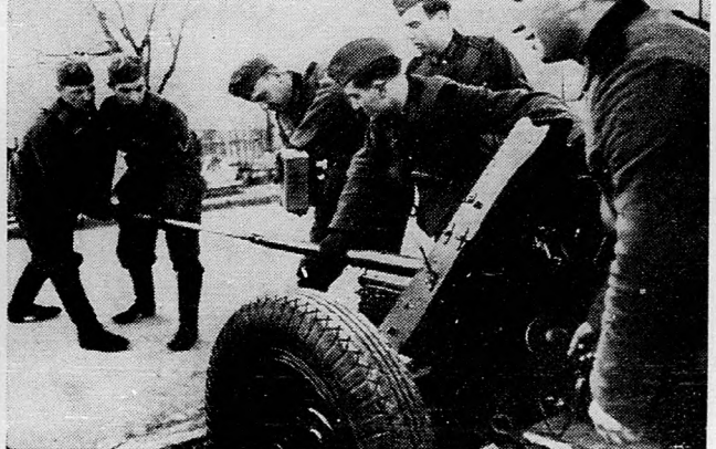
Tisztogatják a páncéltörő ágyú csövét. A harc- és páncéltörőknek ezt a parányi remét terepenő gépkocsikon vontatják, a löveg maga két ballongumis keréken gördül.
