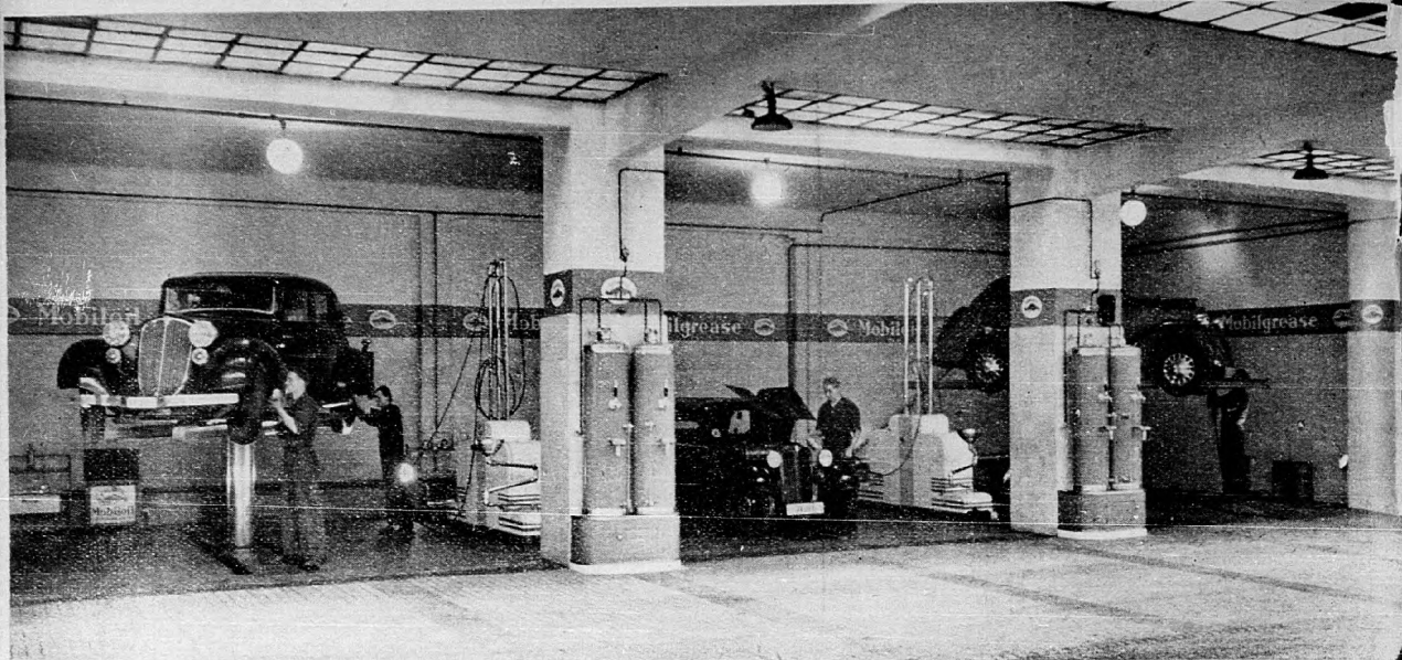
A Metropo-service mosóhelyein emelőbakokon, magasnyomású vizsgárral lemosott kocsikat betanult szerelők, magasemelőkön, pneumatikus úton leszártják, majd nagynyomással dolgozó, modern zsírpórések segítségével lezsírozzák és rozsdamentesítik.
