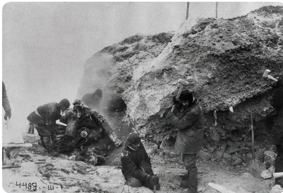
A Balti-Fehér-tengeri csatorna építése, 1931–1933, máglyákat égetnek a talaj felolvasztásához (Gulag-gyűjtemény, Tomasz Kizny)
