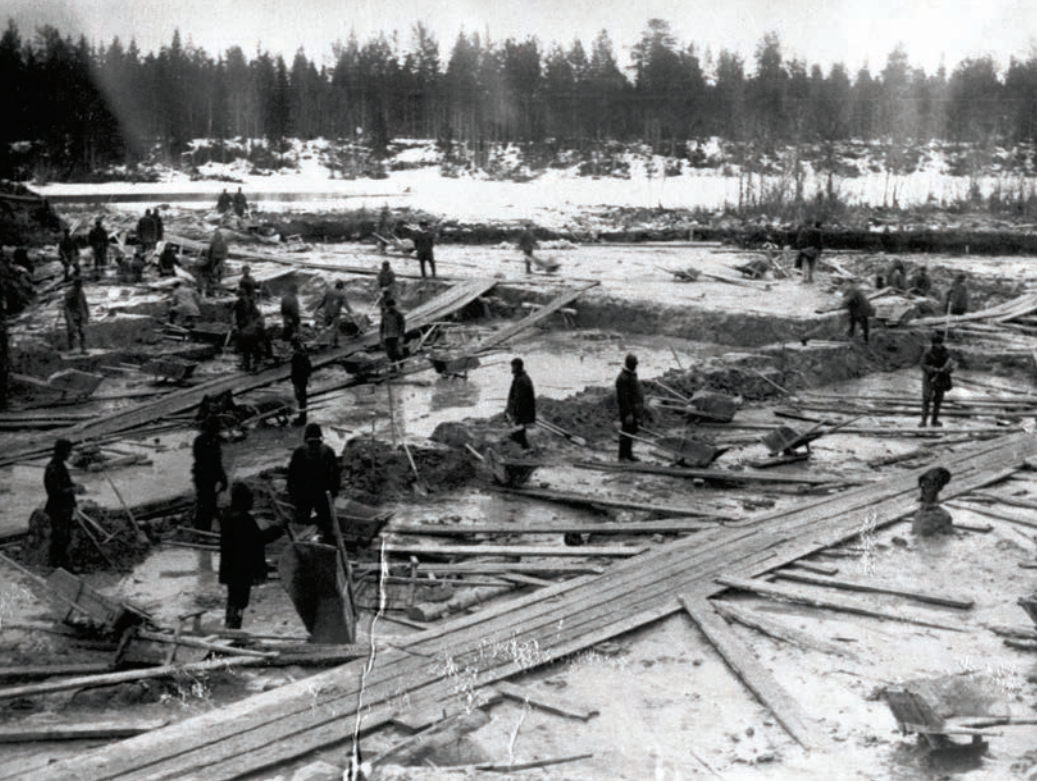
A Balti-Fehér-tengeri csatorna építése, 1931–1933 (Gulag-gyűjtemény, Tomasz Kizny)
