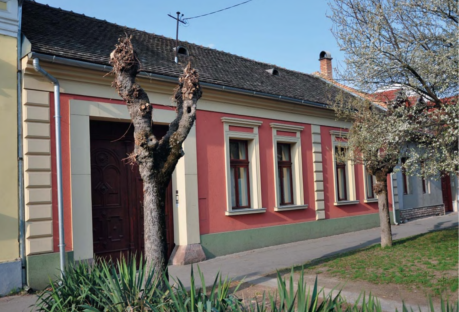
1. kép. Hőszigetelt, felújított utcai homlokzat részlete
