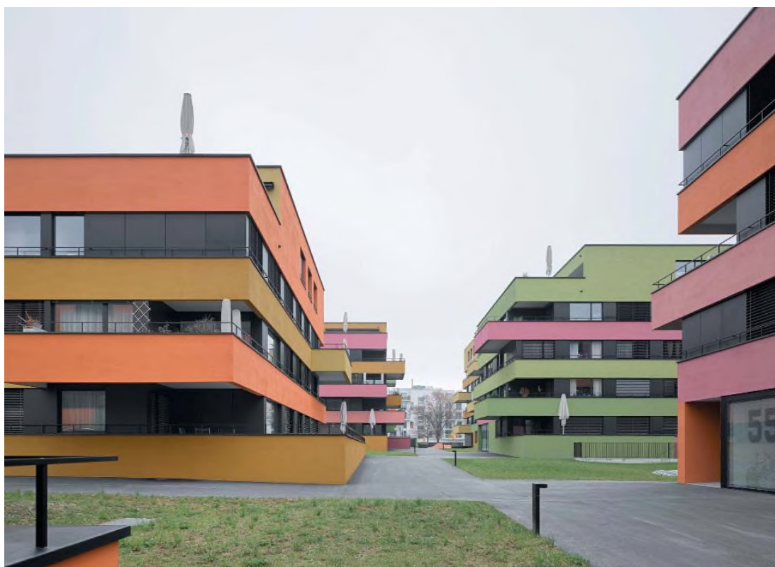
Frohheim lakópark – belső nézet, építés: Arge Em2n – Müller Sigrist, Affoltern, Zürich Szintervező: Jörg Niederberger Fotók: Jörg Niederberger engedélyével
