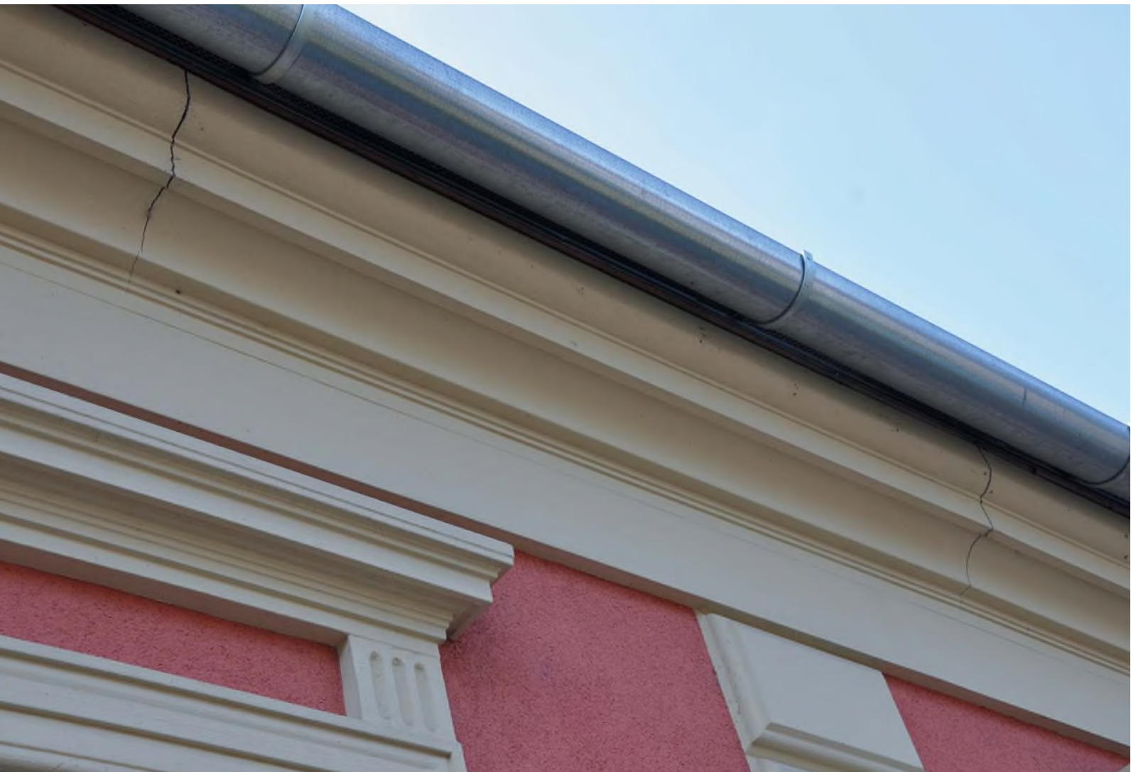
4. kép. A rossz rögzítés miatt megrepedt, valamint a hibátlan állagú vakolatdíszek részlete
