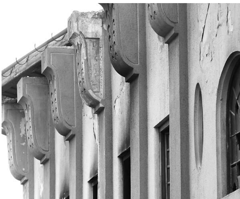
3. kép. A Veszprémi Faipari Rt. igazgatósági épülete, Budapest út
