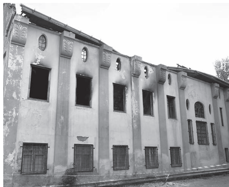
2. kép. A Veszprémi Faipari Rt. igazgatósági épülete, Budapest út
