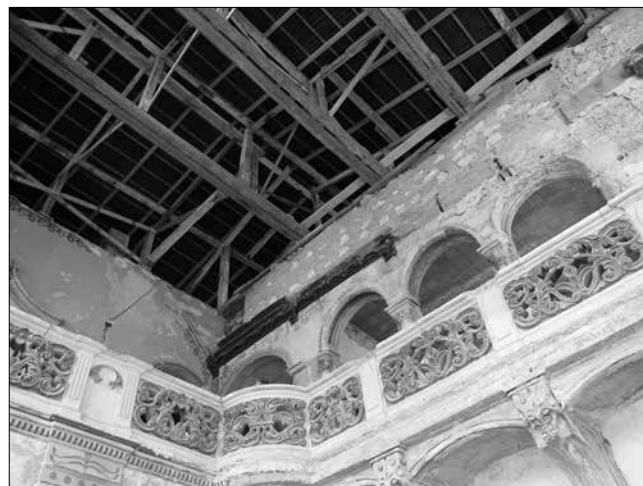
Pucér gerendák tartják a tetőszerkezetet...
