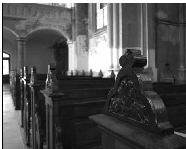
Kifogástalan állapotú padsorok
