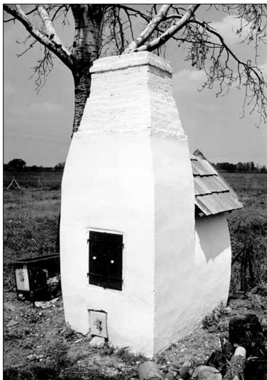
Téglából készült, a sárépítéset gömbölyded formáit követi (Szabadszállás, 1982)
