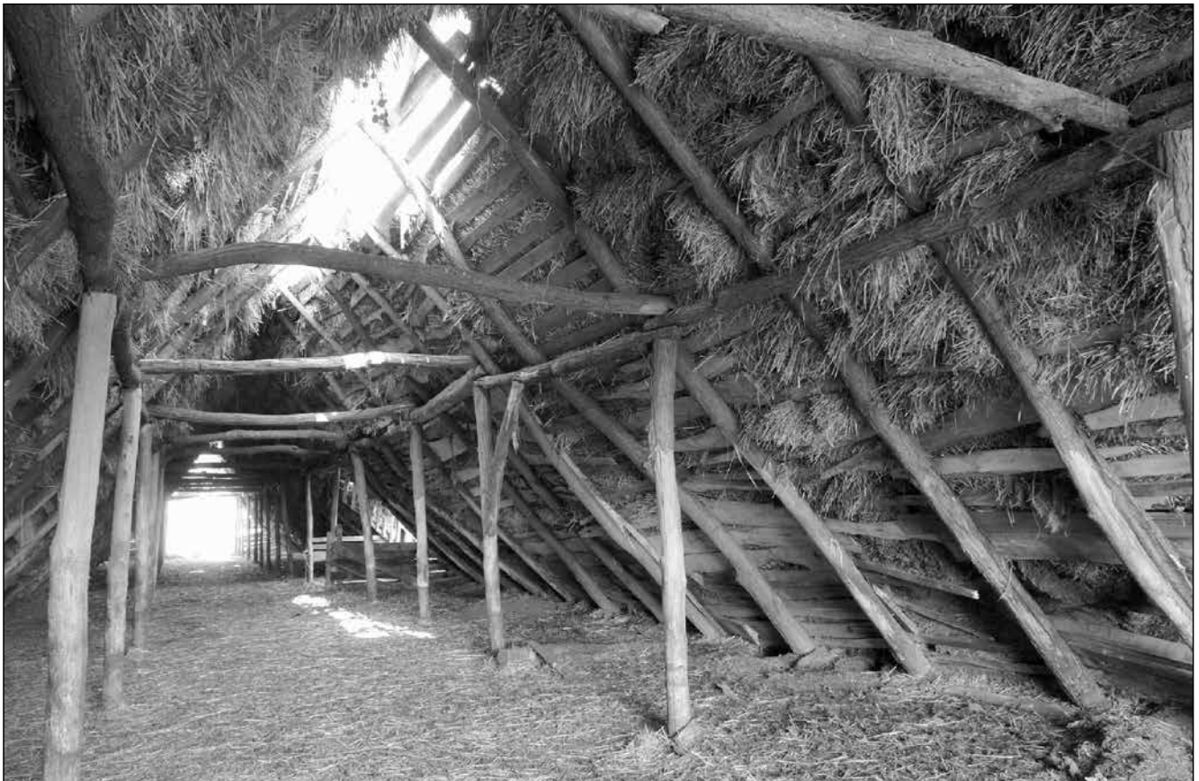
Juhhodály a tavaszi „reparálás” előtt. Ahol nincs nádas, ott szalmával borítják az építmény gerendavázát. (Báránd, 2005)
