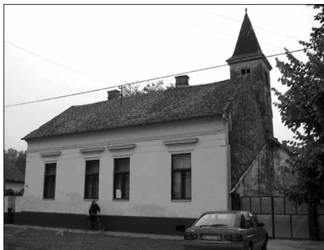
A templom tornya sürgős felújításra vár
