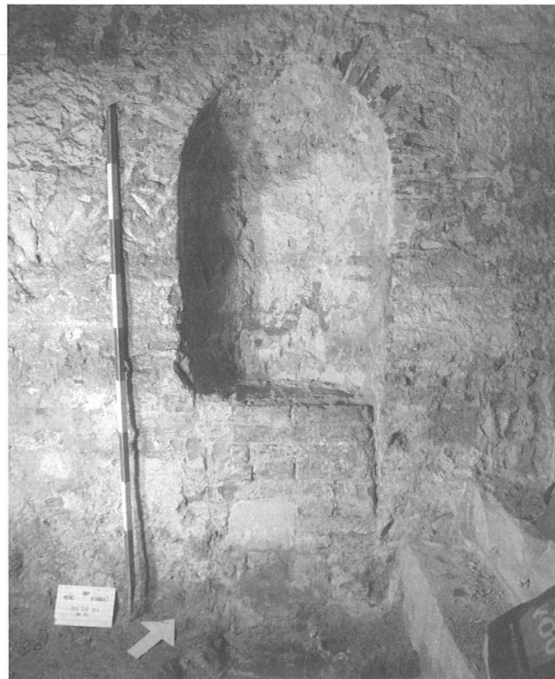
6. kép: Török falfülke, török kori vakolatmaradvánnyal Fig. 6: Turkish niche with the remains of Turkish period plaster
