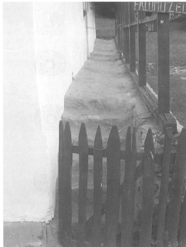
4. kép: Agyaggal tapasztott jelenkori földlépcső Hollókőn
