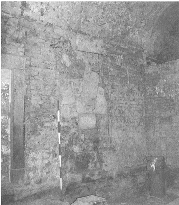
5. kép: Bp., Rudas fürdő. A 26. helyiség északi (török) fala és boltozatindítása: vakolatmaradványok és a török fülke kibontás előtt
