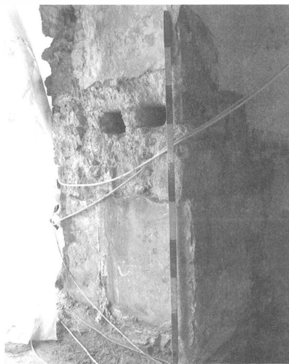
25. kép: Bp., Rudas fürdő. A 25. helyiség északi (török) falában látható koszorúgerenda-fészkek Fig. 25: Bp., Rudas bath. Crossbeam pockets in the northern (Turkish) wall of room no. 25.
