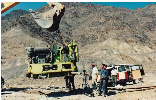
8. ábra. Fúrások előkészítése
