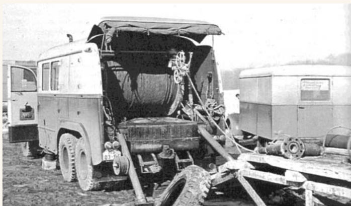
A rétegvizsgálatoknál alkalmazott Tátra karotázs-műszerkocsi
