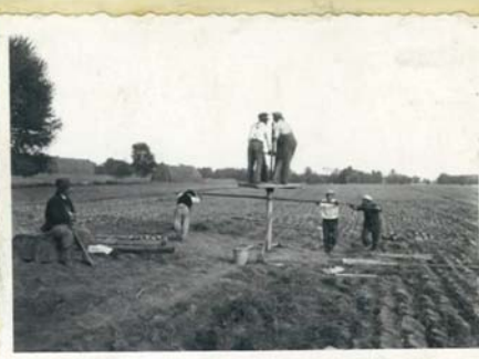
2. ábra. Robbantólyuk fúrása kézi erővel.
