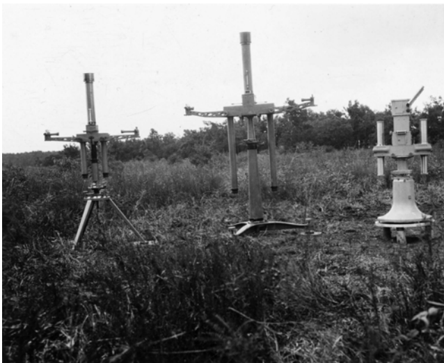
Ingák bemutatása: balról Eötvös-Pekár inga, kettős nagyinga, Askania Z-inga
