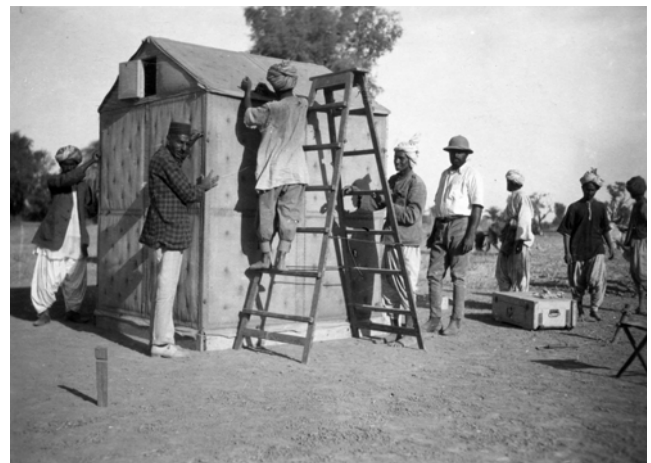
Ingasátor felállítása: Khairpur, India (1923–24)
