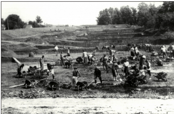
2. kép – A tivadari töltésszakadás helyreállítását végző kubikusok (1948)
