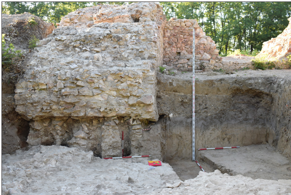
14. kép – A torony délnyugati keresztmetszete az alapozási szintváltásnál megjelenő cölöphelyekkel (fotó: Szabó Renáta)
