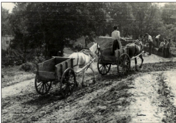
3. kép – A tivadari gátszakadás helyén az új töltés építése kordélyos munkával (1948)
