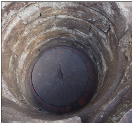
10. kép – A kváderekből rakott ciszterna teljesen megtisztítva a törmeléktől (fotó: Szabó Renáta)
