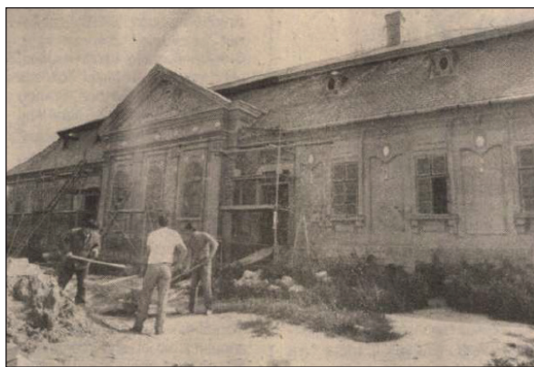
A kastély felújítása 1990-ben
