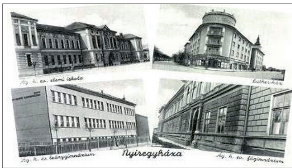
Az elemi iskola épülete, egyben a gimnázium első ideiglenes helye és a saját épület a Jósza András utca 2–6. sz. alatt (ma a Nyíregyházi Vasvári Pál Gimnáziumnak ad otthont)
