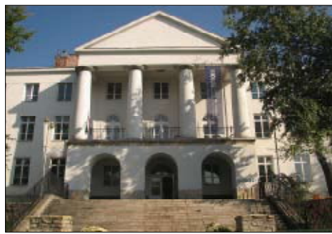
26. kép. A MOME hangsúlyos főbejárata
