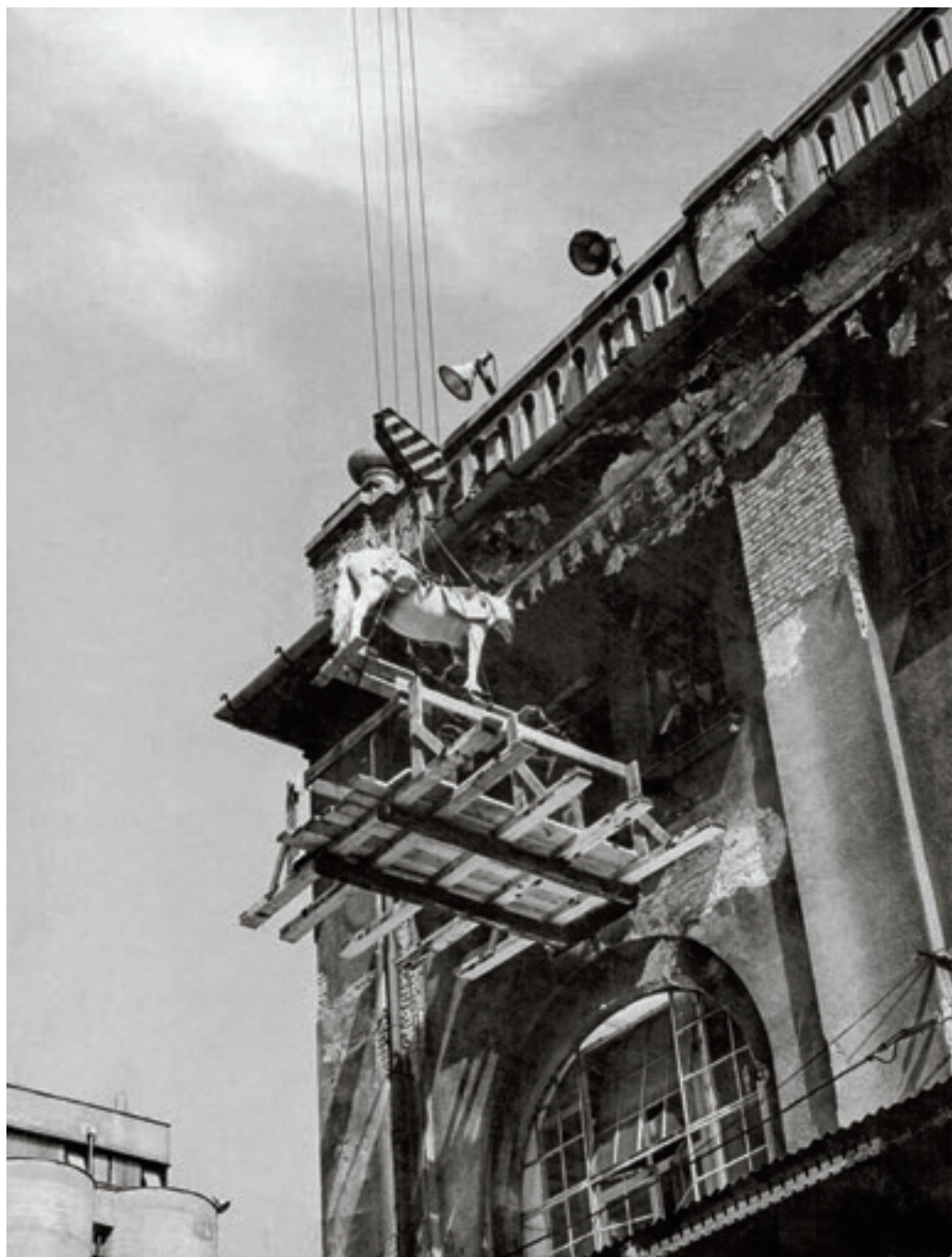
A preparált lovak beemelése a Söripari Emléktár első kiállításába A Dreher Sörgyárak Zrt. jóvoltából
