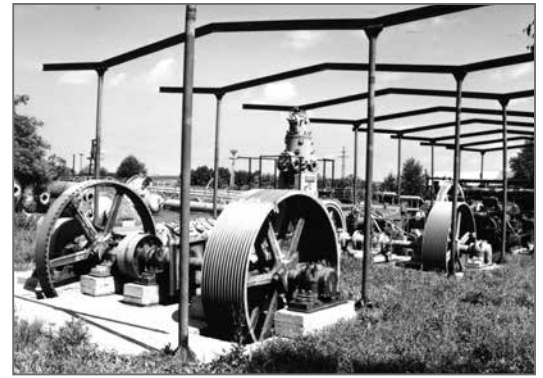
1986. Készül a Kompresszorház
