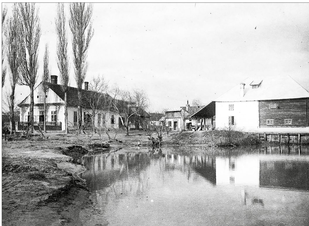
A Gömbös-malom átépítés után
