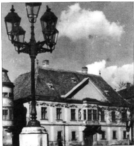
Karos gázlámpa Győrben. (A gázlámpákat évtizedeken keresztül nem földgázzal, hanem a XIX. század közepétől egymás után létesülő városi gázgyárakban szénből előállított „városigázzal” működtették)
