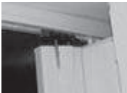
2. ábra: Régi beltéri ajtó rögzítő szerkezete
