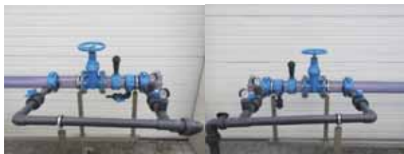
3. ábra. a. – az „indítókamra”, b. – a „fogadókamra” fényképe
