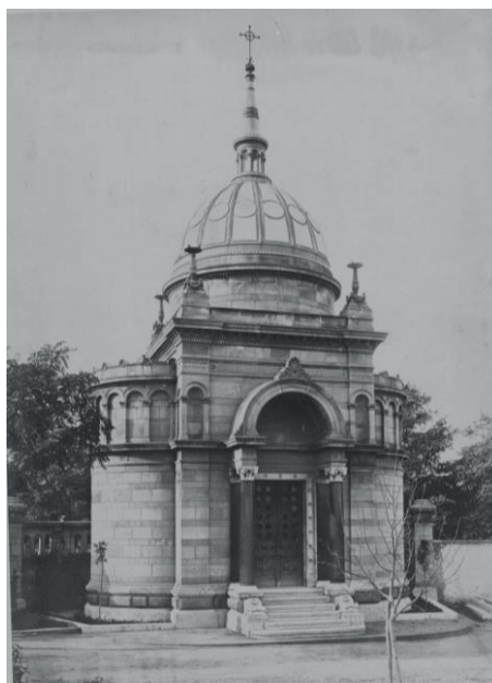
4. ábra. Ganz Ábrahám mauzóleuma a Fiumei úti sírkertben (tervezte Ybl Miklós)
