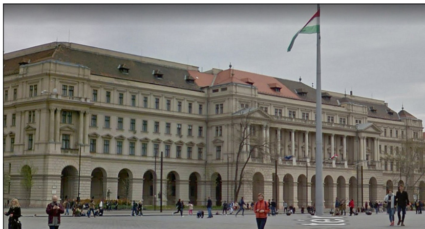
4. ábra. Kossuth tér 11. A minisztérium épületében működött 1967 és 1990 között az OFTH.
