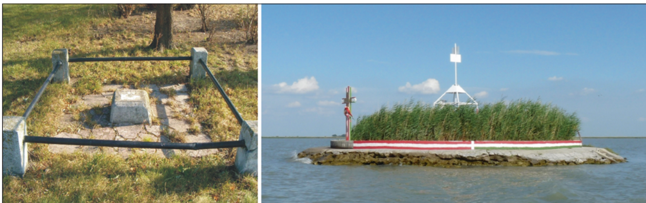
A gellérthegyi Citadellában lévő vetületi kezdőpont és a „B” határjel a Fertő tóban (a szerző felvételei)
