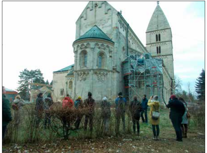
■ 1. kép: Szakmai kirándulás a jáki templomnál, ahol a munka vezetője, SARKADI Márton ismerteti a felújítást a fiatal szakembereknek © VEÖREŐS András ■ Photo 1. Study field trip to the church in Ják, where the project manager, Márton SARKADI presents the conservation works to young professionals © András VEÖREŐS
