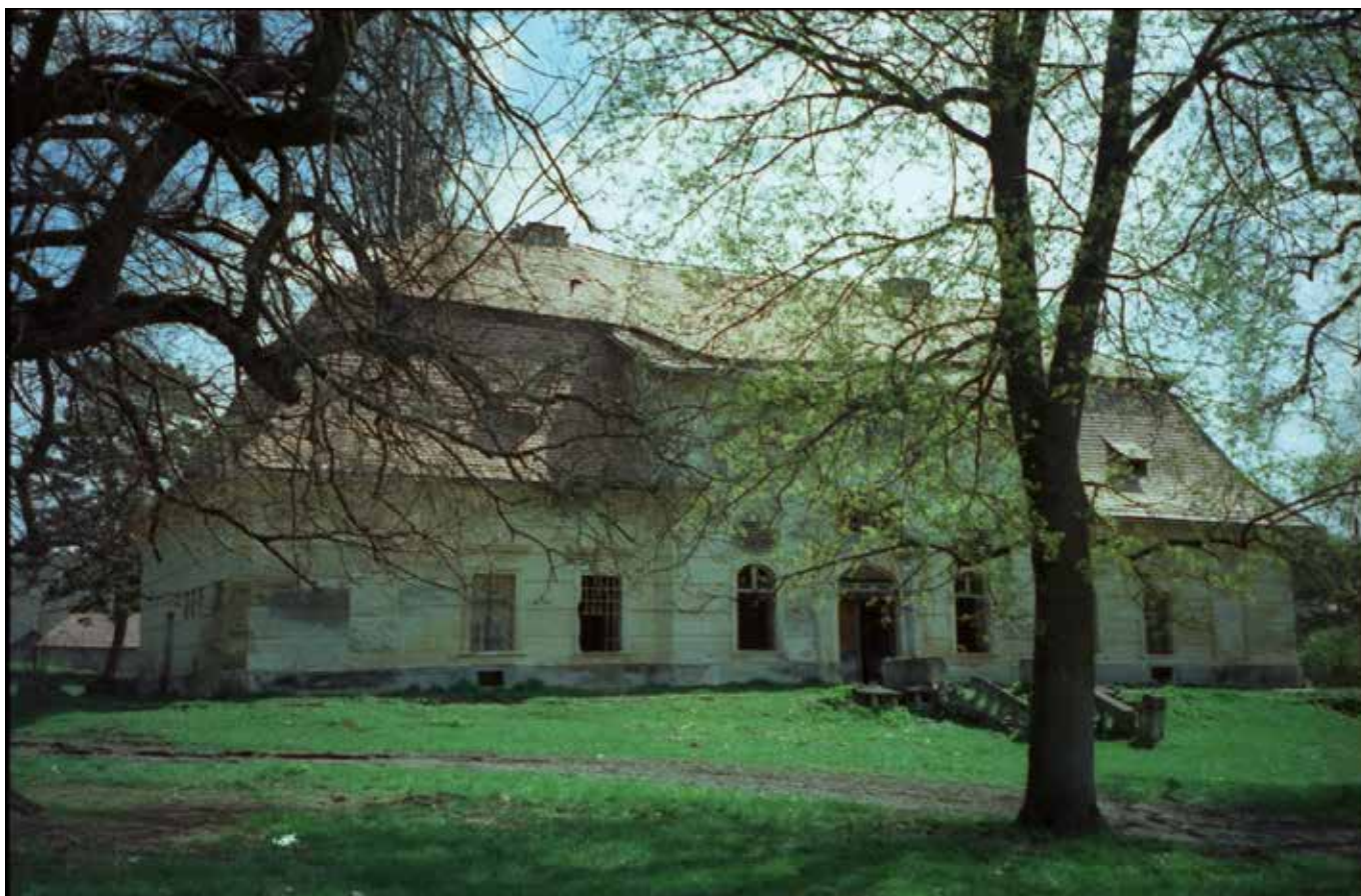
■ Foto 3. Fațada dinspre parc la începutul anilor 1990 © Corneliu GAIU
