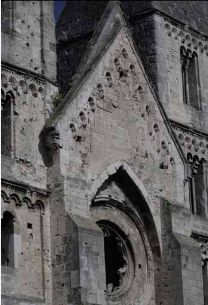
■ 3. kép: A nyugati oromfal hátrahorgonyzása © MEZŐS Tamás ■ Photo 3. Anchoring the western gable © Tamás MEZŐS
