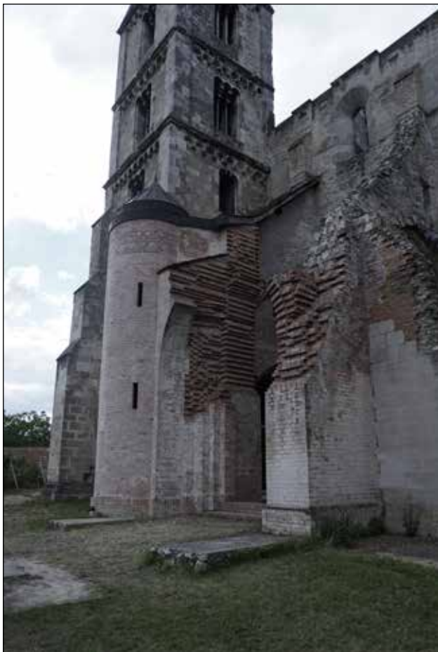
■ 8. kép: A déli kapu részleges rekonstrukciója © MEZŐS Tamás ■ Photo 8. Partial reconstruction of the southern portal © Tamás MEZŐS
