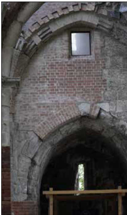
■ 10. kép: A déli torony megnyújtott terének lefalazása © MEZŐS Tamás ■ Photo 10. Masonry closing the enlarged space of the southern tower © Tamás MEZŐS
