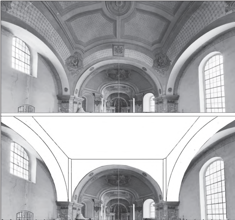
■ Fig. 4. Colaj foto. În situația inițială, arcele de pe nord și de pe sud se aflau mai sus, la cota indicată de tencuiala din pod © Marius Mihail PĂSCULESCU ■ Figure 4. Photo collage: initially, the arches on the north and south were higher, at the level indicated by the plaster in the attic © Marius Mihail PĂSCULESCU
