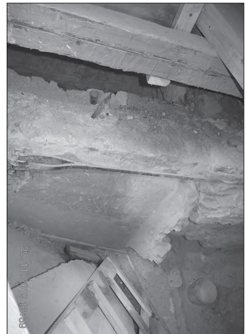
■ Foto 7. Urmă de tencuială pe zidăria de peste arcul vestic © Marius Mihail PĂSCULESCU
