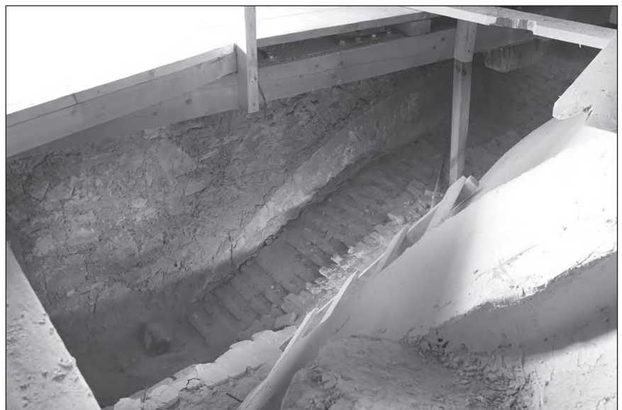
■ Foto 6. Urmă de tencuială la extradosul arcului de pe perețele nordic © Marius Mihail PĂSCULESCU
