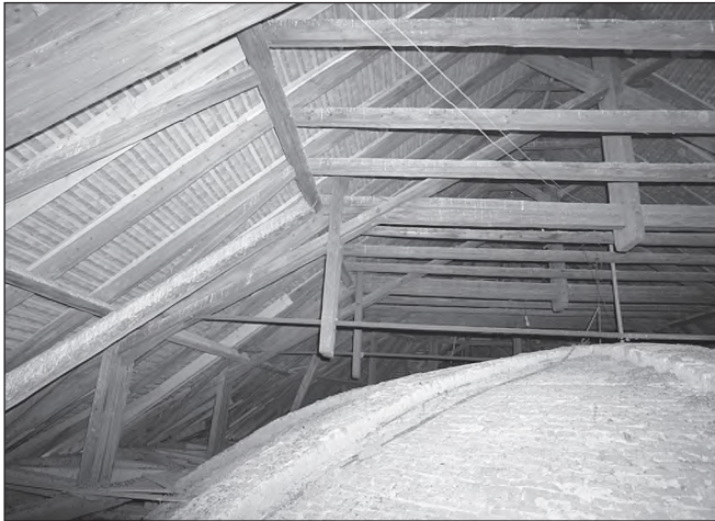
■ Foto 4. Bara de agățare scurtată și montarea tirantului © Marius Mihail PĂSCULESCU
