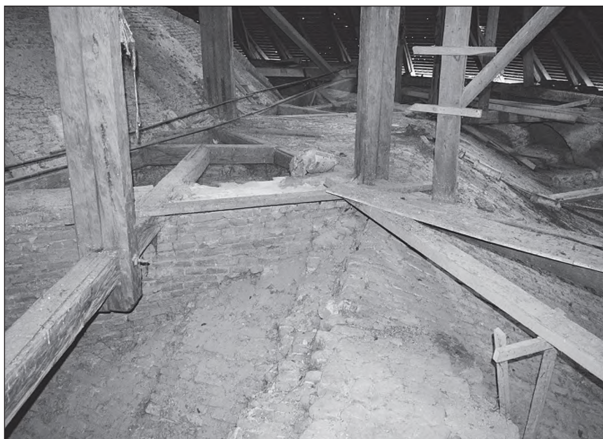
■ Foto 3. Extradosul bolții de la foto 2 © Marius Mihail PĂSCULESCU ■ Photo 3. The extrados of the vault from photo 2 © Marius Mihail PĂSCULESCU
