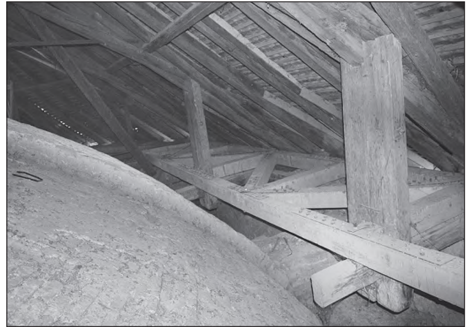
■ Foto 5. Coardă secționată. Grinda zăbreilită reprezintă o intervenție modernă © Marius Mihail PĂSCULESCU
