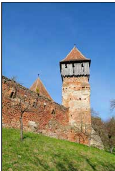
■ Foto 7. Alma Vii, Turnul Clopotelor înainte de restaurare © MET
