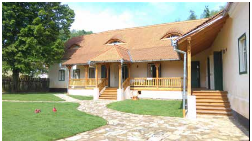
■ Foto 20. Richiş, Casa Richiş după restaurare © MET
