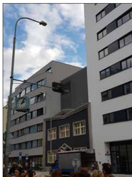
■ Foto 14. . Cartierul Holešovice din Praga, Republica Cehă. Din clădirea cubistă a fabricii de vopsele Materna a fost păstrată numai faţada, integrată într-o dezvoltare imobiliară de mare amploare realizată în 2017-2018 © Rodica CRIŞAN 2019
