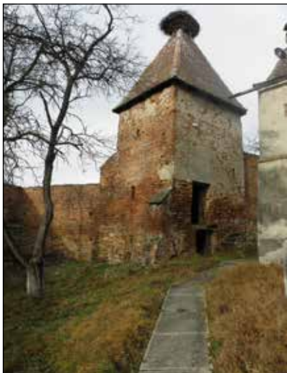
■ Foto 5. Alma Vii, Turnul Grânelor înainte de restaurare © MET
