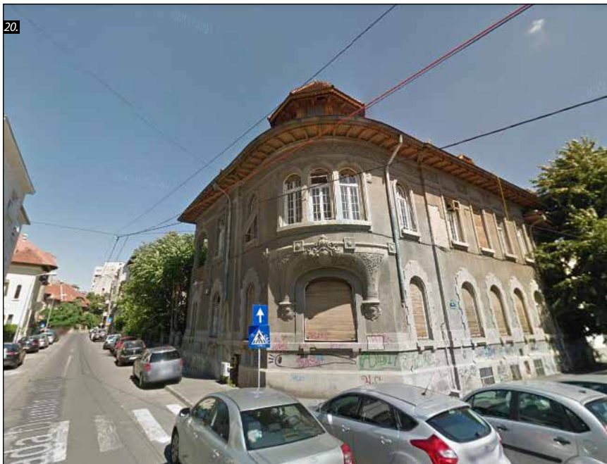
■ Foto 20-22. București, str. Dumbrava Roșie (zona protejată nr. 40). Villă neo-românească bine conservată, demolată [foto 20, captură de imagine iulie 2014 © 2020 Google] cu păstrarea fațadelor integrate într-o dezvoltare imobiliară de mari dimensiuni © Rodica CRIȘAN 2019, 2020
