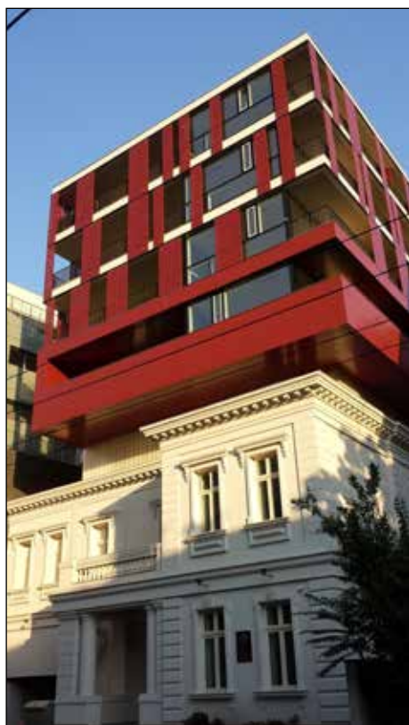
■ Foto 27. București, Str. Gheorghe Manu nr. 7 (zona construită protejată nr. 97). Construcție nouă care înglobează fațadele casei Spiru Haret, în zona de protecție a monumentului clasat Casa Niculescu-Dorobanțu © Rodica CRIȘAN 2015
