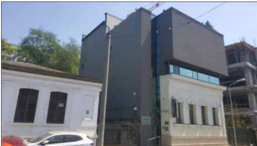
■ Foto 28. București, Calea Șerban Vodă nr. 35. Construcție nouă dezvoltată pe verticală înglobând fațadele unei case de locuit tipice pentru țesutul tradițional, alături de monumentalul clasat Casă de târgoveț de la nr. 33 © Rodica CRIȘAN 2018
