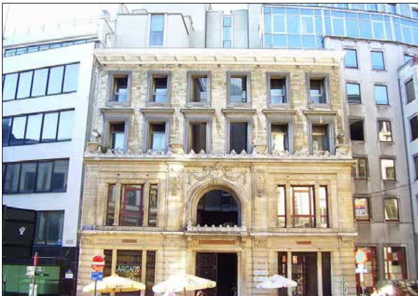
■ Foto 12. Bruxelles, Belgia. În centrul oraşului, o faţadă-ecran din 1905 a fost integrată într-o clădire din 1985 © Ben2, 2006. CC BY-SA 3.0
