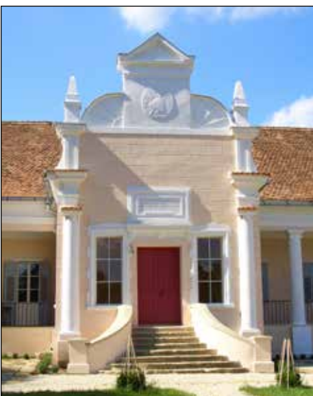
■ Foto 16. Mălâncrav, Conac Apafi, intrare principală după restaurare © MET ■ Photo 16. Mălâncrav, Apafi Manor, main entrance after conservation © MET
