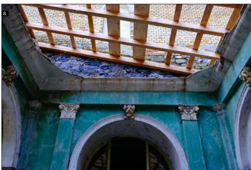
■ Foto 6-8. Băile Neptun în timpul șantierului de punere în siguranță, 2019 © Martin NEAGOE ■ Photo 6-8. Băile Neptun during the securing works, 2019 © Martin NEAGOE
