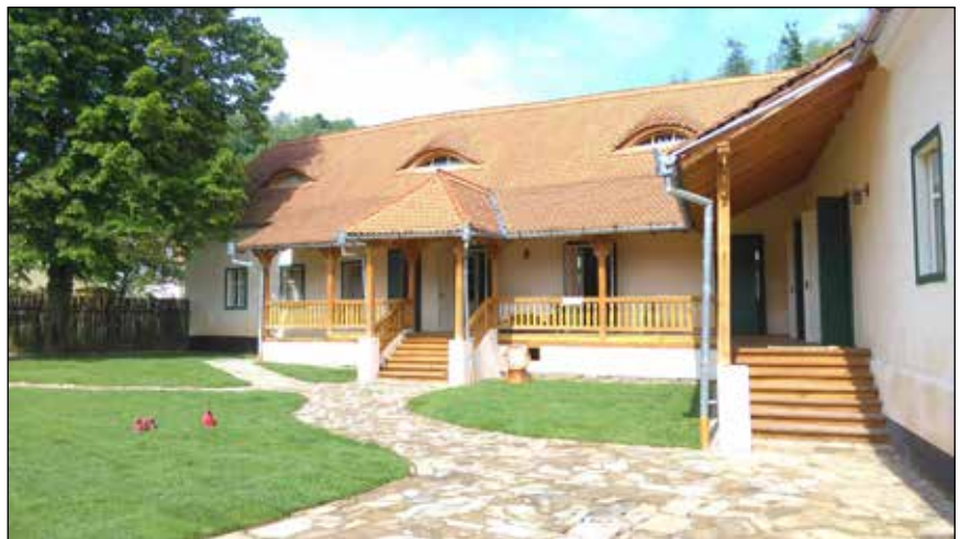
■ Foto 20. Richiş, Casa Richiş după restaurare © MET
