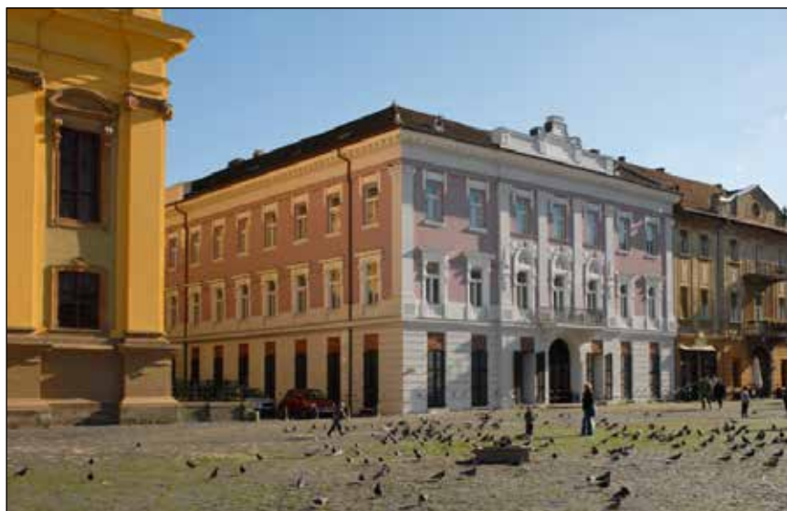
■ Foto 3. Piața Unirii nr. 13 – fațada principală © Bogdan DEMETRESCU ■ Photo 3. 13 Unirii Square – main elevation © Bogdan DEMETRESCU
