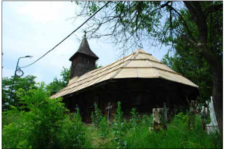
■ Foto 8. Biserica de lemn din Crivina de Sus înainte de primul workshop în 2013. Biserica în care ploua de peste 10 ani a fost protejată cu o membrană de către noul preot din sat. Cimitirul era năpădit de buruieni © Diana BELCI
