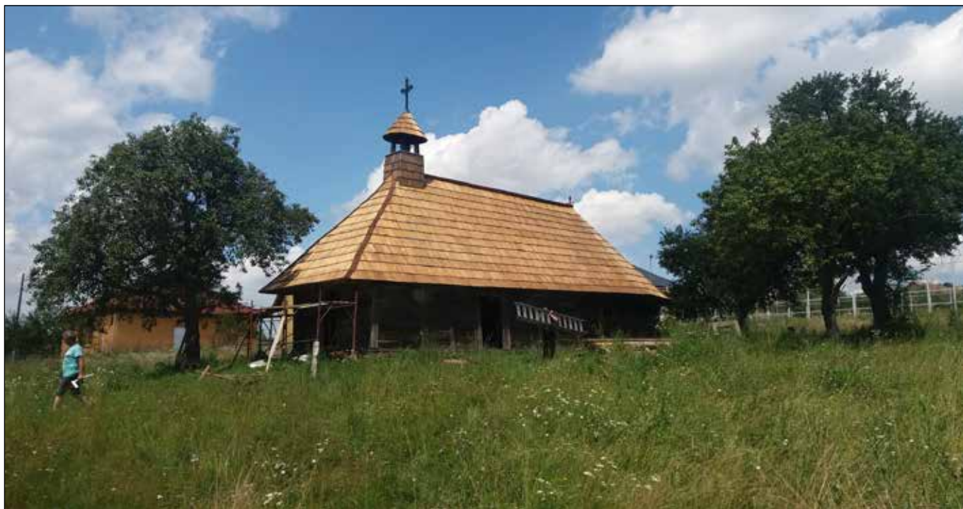
■ Foto 7. Biserica de lemn din Dragomirești după încheierea șantierului © Diana BELCI ■ Photo 7. The wooden church in Dragomirești after the intervention © Diana BELCI
