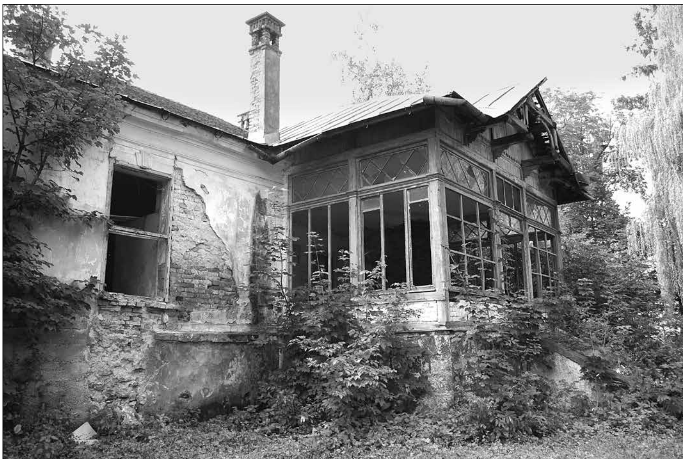
■ Foto. 10. Grădina de iarnă/veranda de pe fațada vestică a castelului Mikes © Andreea MILEA, 2009 ■ Photo. 10. Winter garden/veranda on the western elevation of the Mikes Manor House © Andreea MILEA, 2009
