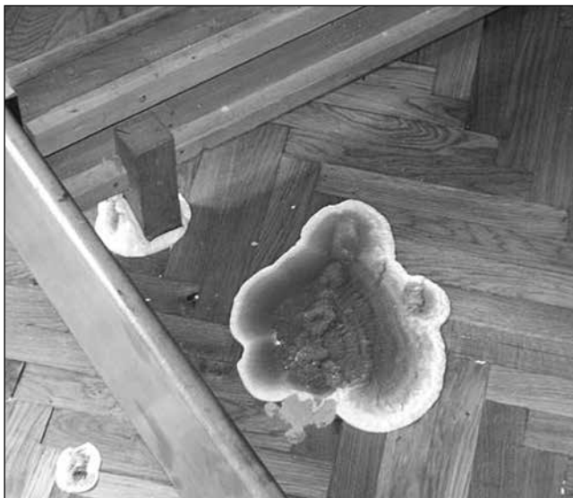
■ 1. kép: A könnyező házigomba termőteste ■ Photo 1. The sporophore of the dry rot fungus
