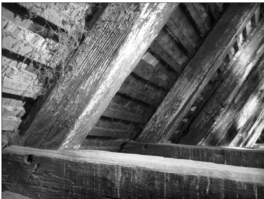
■ 5. kép: A szentély feletti tetőszerkezet déli szarufái. Állásjelek a 12. és 11. állásban. Csapolt szarufákötőgerenda kapcsolatok, 2012
