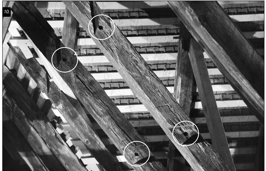
■ 9. kép: Kötőgerendákon megfigyelhető üres lapolási fészkek a négyezet feletti szerkezetben
