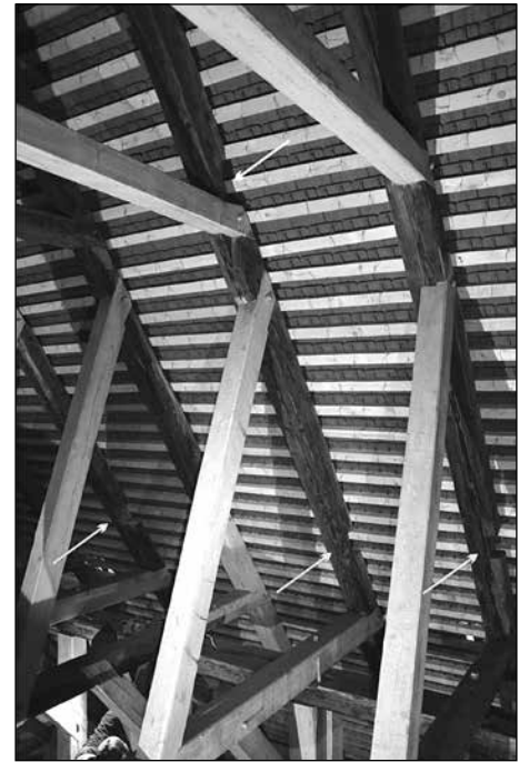
■ 17. kép: A hajó feletti tetőszerkezetben a szarufákon látható használaton kívüli lapolási fészkek, 2016. Piros nyíl: vízszintes lapolási fészék, sárga nyíl: függőleges lapolási fészék
