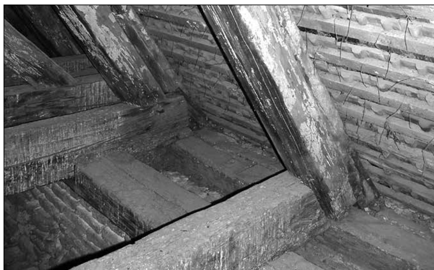
■ 16. kép: Lapolt és csapolt szarufa–kötőgerenda kapcsolat a főhajó feletti szerkezetben, egymás melletti állásokban
