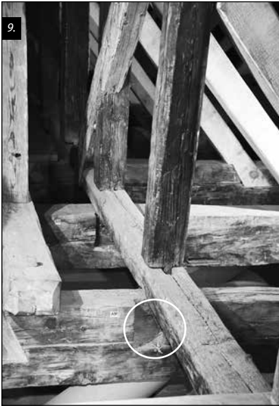
■ 9. kép: Kötőgerendákon megfigyelhető üres lapolási fészkek a négyezet feletti szerkezetben
