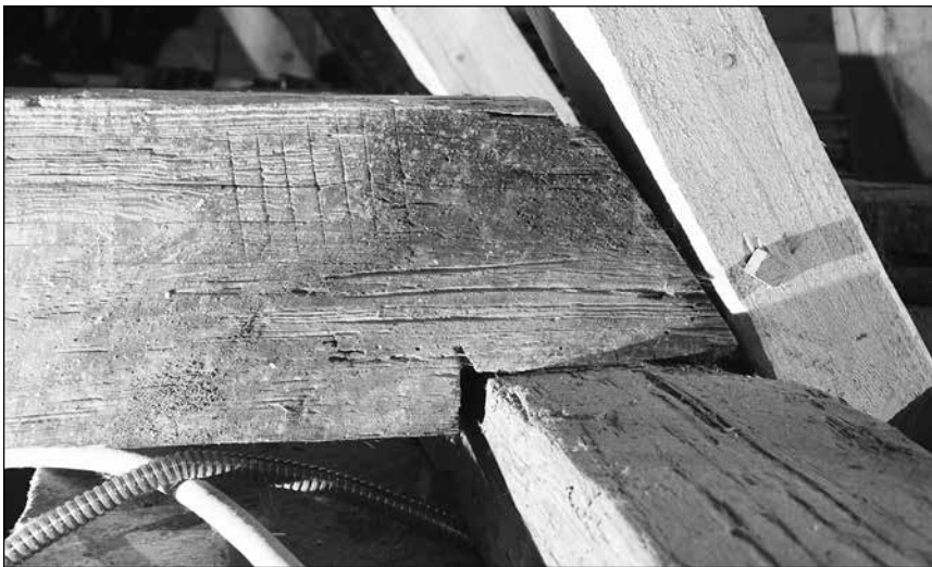
■ 11. kép: A négyezet feletti A30. állás kötőgerendájának déli végén megfigyelhető kétféle állásjel, 2016
