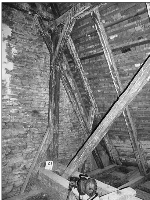
■ 20. kép: A déli mellékhajó feletti E tetőszerkezet nézete ■ Photo 20. View of roof structure E above the southern aisle
