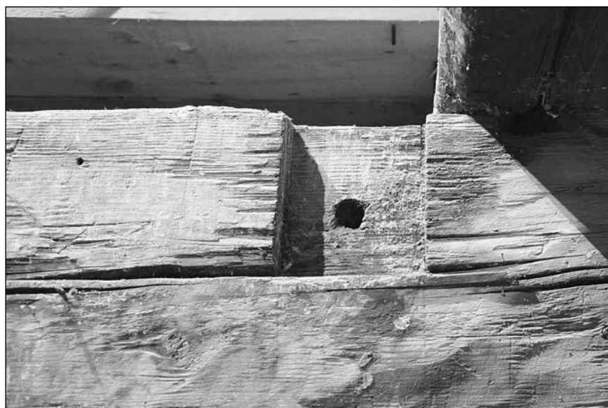
■ 12. kép: A négyzet feletti A27. állás kötőgerendáján a használaton kívüli lapolási fészeknél megfigyelhető állásjel
