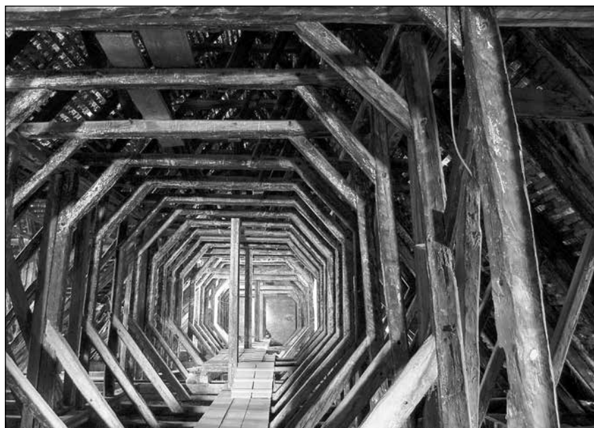
■ 15. kép: A főhajó feletti tetőszerkezet keletről, 2012
