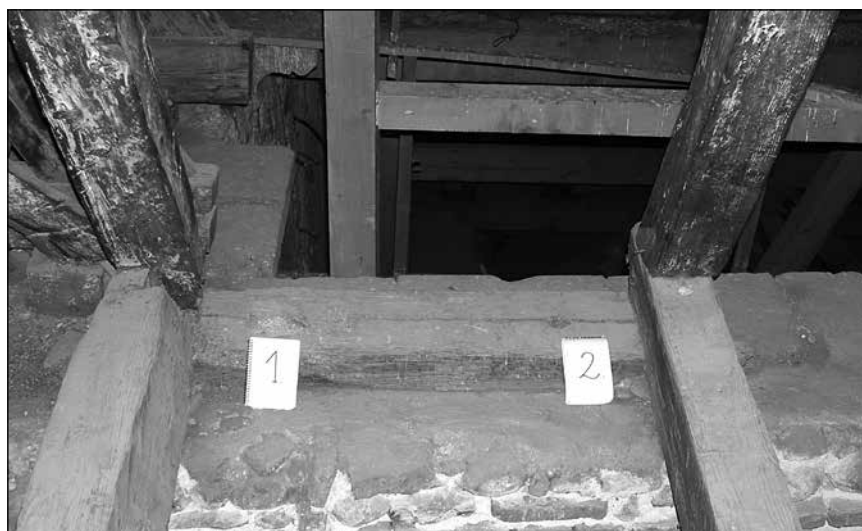
■ 4. kép: A szentély feletti fedélszerkezet északi szarufáinak kapcsolódása a kötőgerendához nyugatról az 1. és 2. állásban. Az 1. állásban a kötés lapolt, a 2. állásban csapolt, 2012
