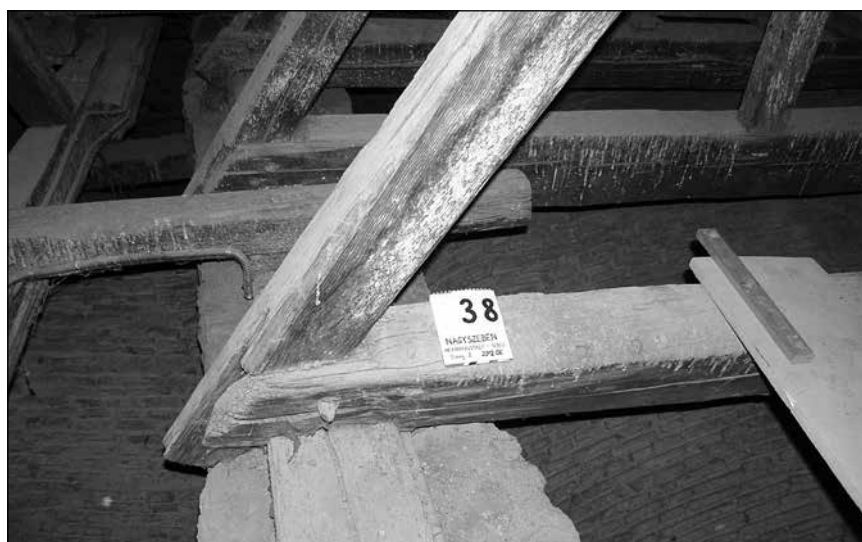
■ 7. kép: Lapolt szarufa–kötőgerenda kapcsolatok a négyezet feletti tetőszerkezetben, 2012
