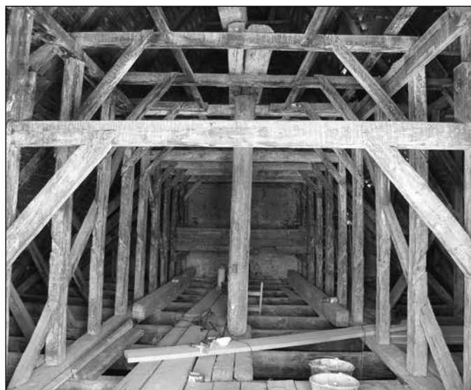
■ 18. kép: A ferula középhajója feletti tetőszerkezet nyugatról, 2012 ■ Photo 18. The roof structure above the ferula's central nave, as seen from the west, 2012
